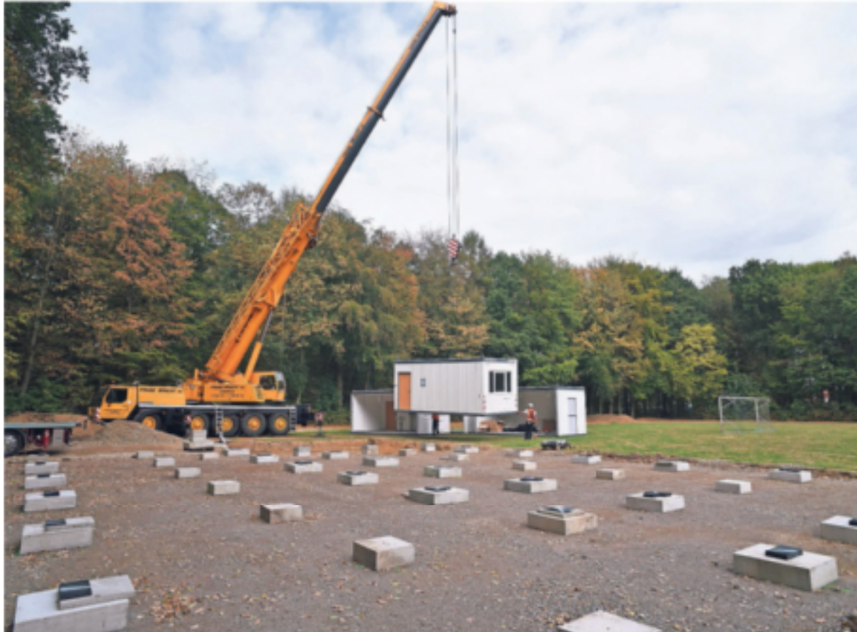
Die neuen Klassenräume schweben am Kran hängend ein.
