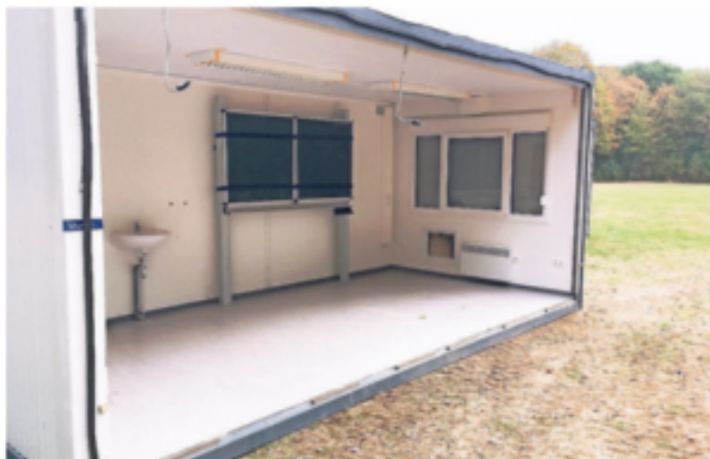
Drei solcher Module werden zum einem 50 Quadratmeter-Raum zusammengebaut, der über Fenster, Tür, Heizung, Waschbecken und Tafel verfügt.
