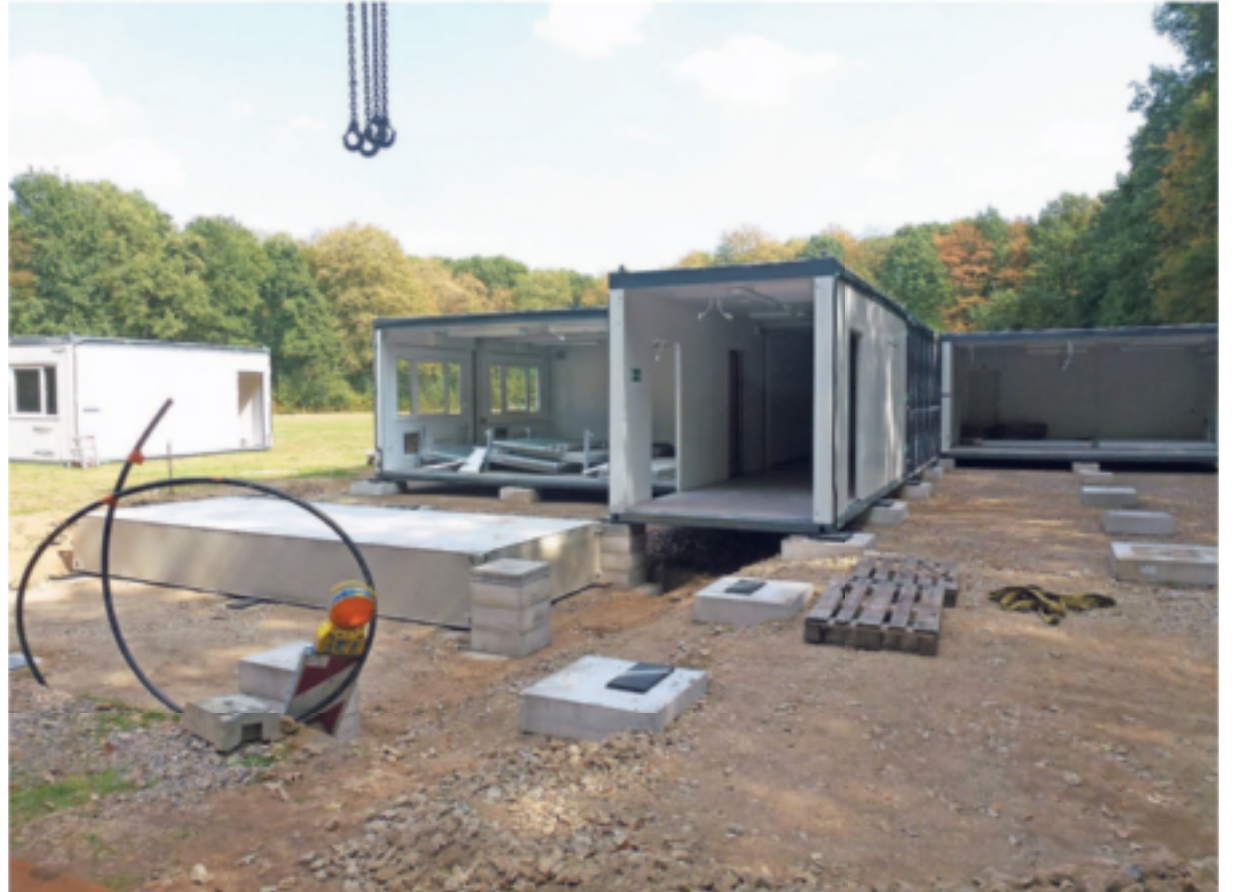
Die Container-Module werden auf Punkt-Fundamenten platziert.
